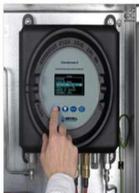
**Analizador de punto de rocío de hidrocarburos - Michell Condumax II**
